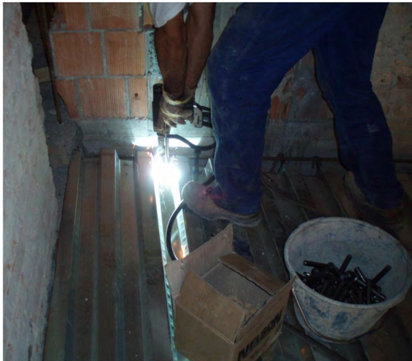
Saldatura connettore Nelson
