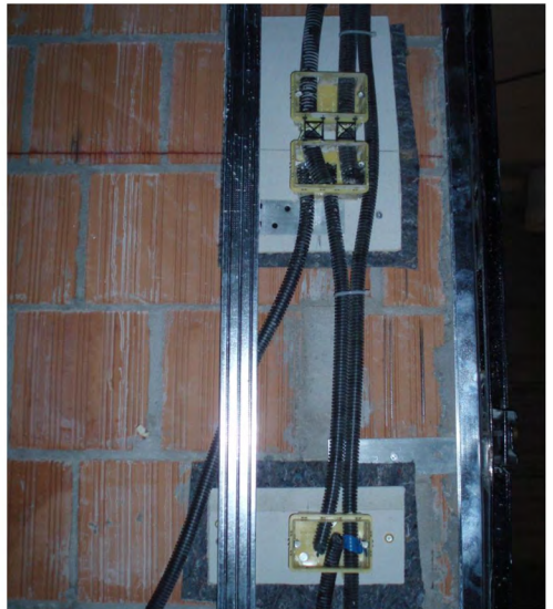
Dettagli di risoluzione dei ponti acustici
