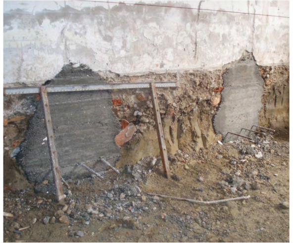
Consolidamento delle fondazioni esistenti in corrispondenza della muratura perimetrale
