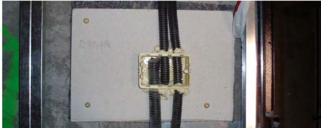
Dettagli di risoluzione dei ponti acustici
