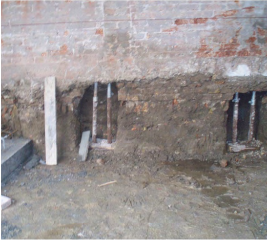
Consolidamento delle fondazioni esistenti in corrispondenza della muratura perimetrale
