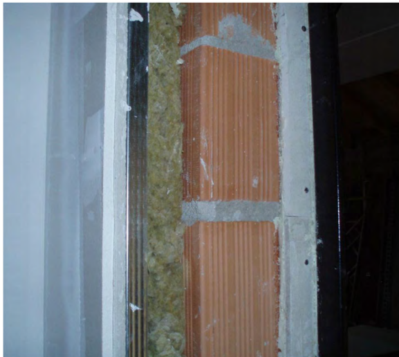
Muro divisorio tra unità e unità
