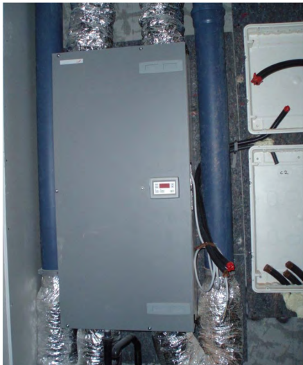
Impianto di ventilazione meccanica controllata VMC
