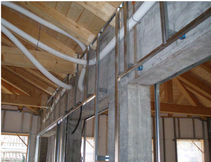
Impianto di ventilazione meccanica controllata VMC
