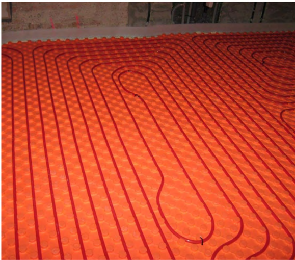
Impianto di riscaldamento radiante a pavimento, serpentine e collettori
