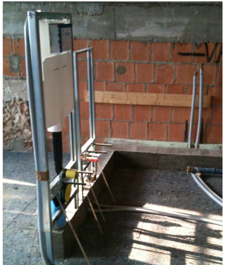
Tnt anticalpestio sotto impianti
