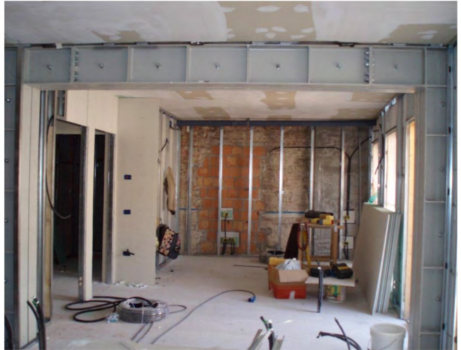
Sistemi di sostegno delle murature per formazione dei varchi
